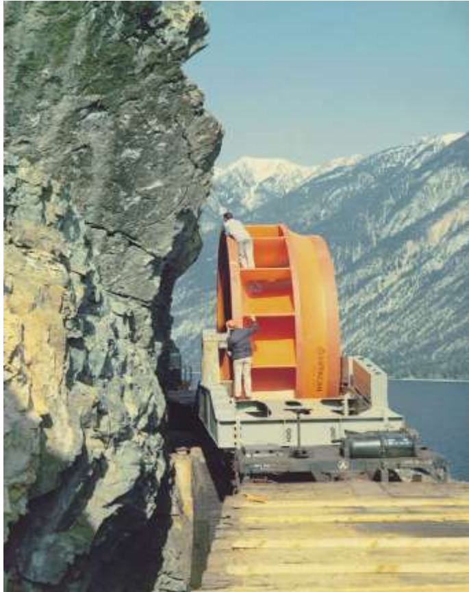
カナダマイカ発電所納め 水車ランナの輸送作業
