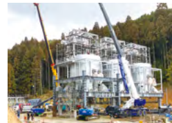
乾溜ガス化燃焼プラント設備据付
