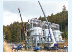
乾溜ガス化燃焼プラント設備据付
