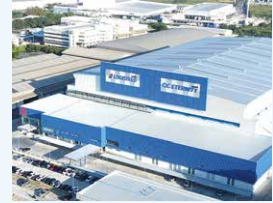
タイ:テパラックロジスティクスセンター
