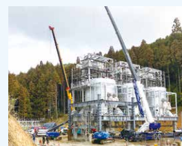
乾溜ガス化燃焼プラント設備据付
