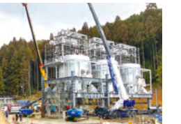
乾溜ガス化燃焼プラント設備据付
