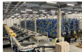
ロボティクス自動倉庫
