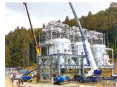
乾溜ガス化燃焼プラント設備据付
